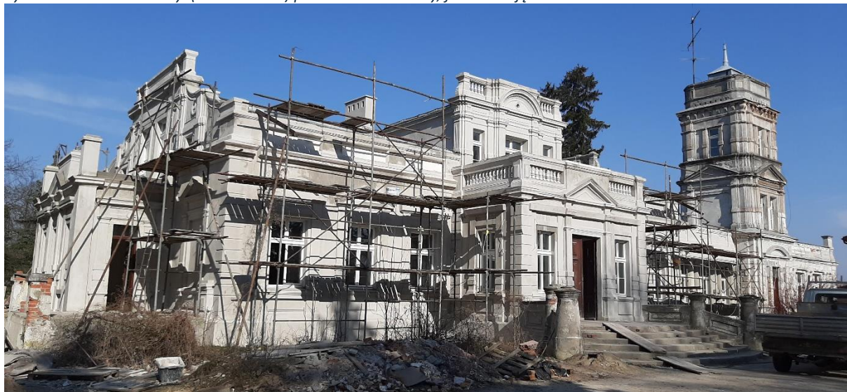
Rysunek 15 Remontowany (od 2023 roku) pałac w Mieczownicy, fasada. Zdjęcie – 2025 rok.
