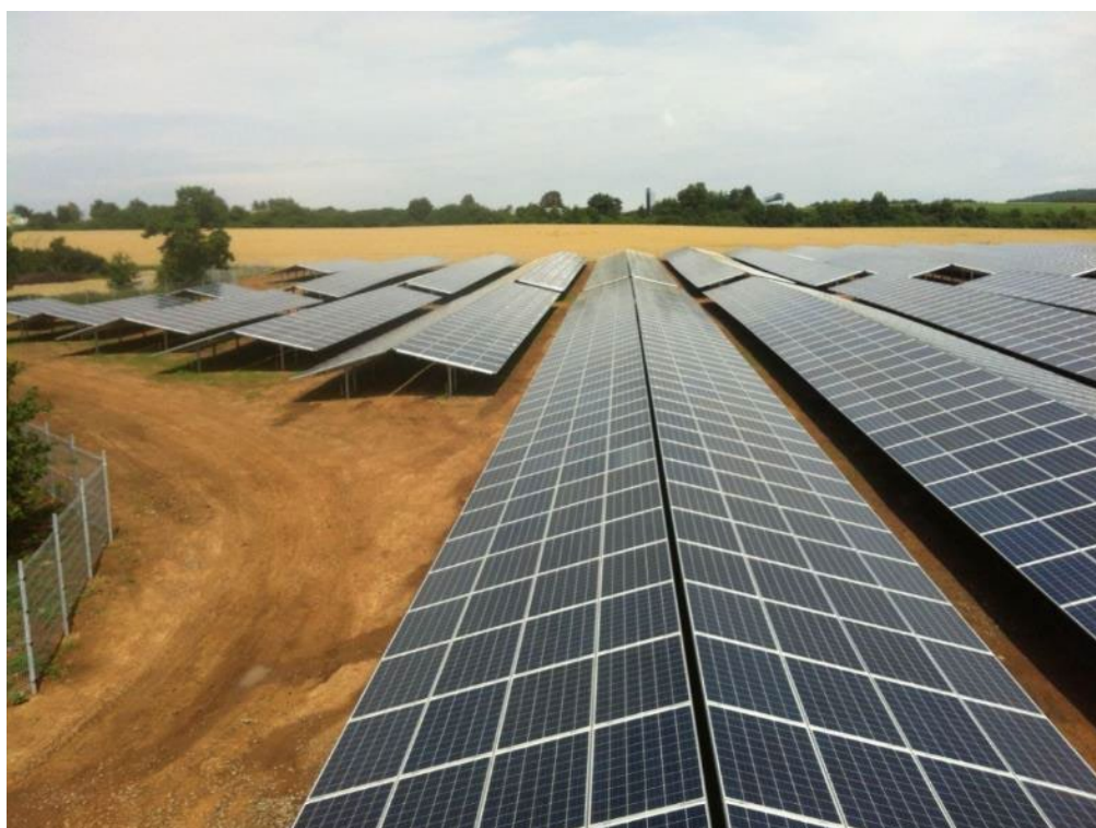
Fotografia 8 Przykład elektrowni w układzie paneli wschód-zachód. Pozostawiona niewielka ścieżka technologiczna, dająca dostęp do terenu pod panelami – możliwe przyszłe użytkowanie rolne. (źródło: https://www.abc-solar.com/ dostęp z dnia 21.10.2019)
