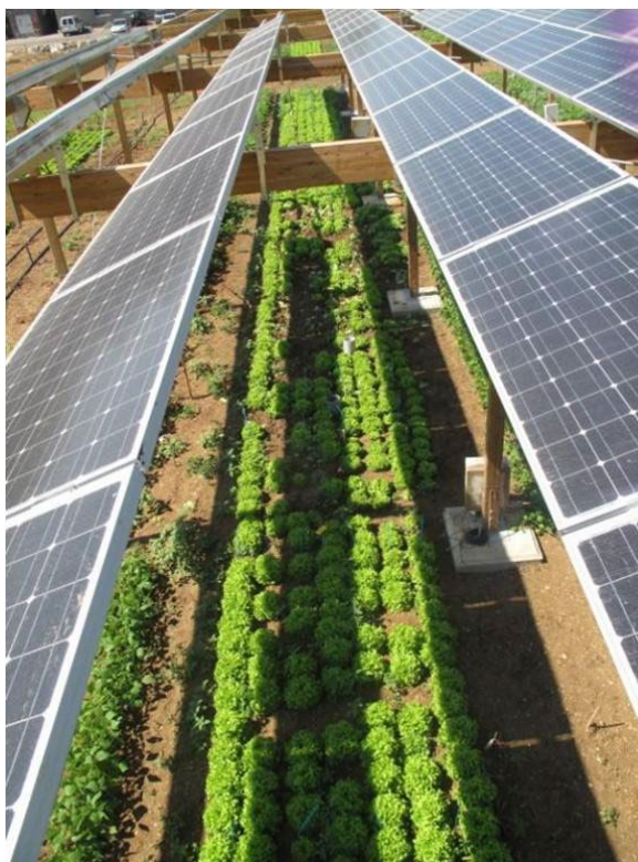
Fotografia 6 Przykład zainstalowanej elektrowni fotowoltaicznej na gruncie, który jest nadal użytkowany rolniczo
