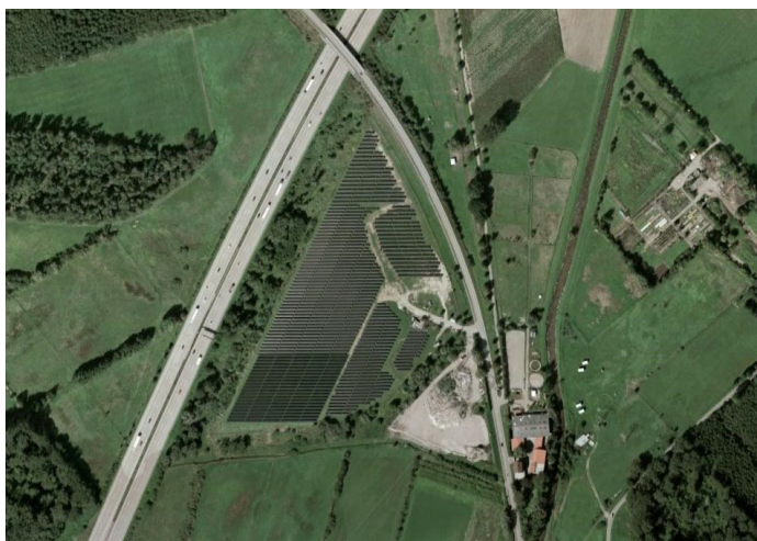
Fotografia 5 Elektrownia fotowoltaiczna w Iffezheim (źródło: Google maps)
