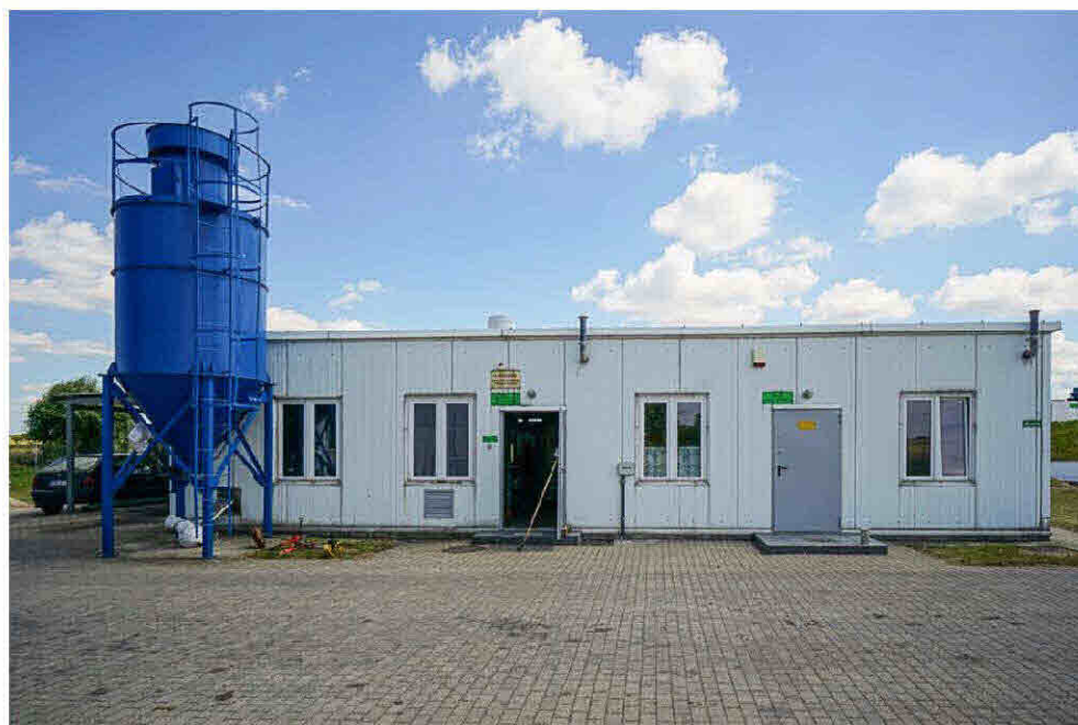
Fot 12 Budynek prasy z węzłem higienizacji osadu
