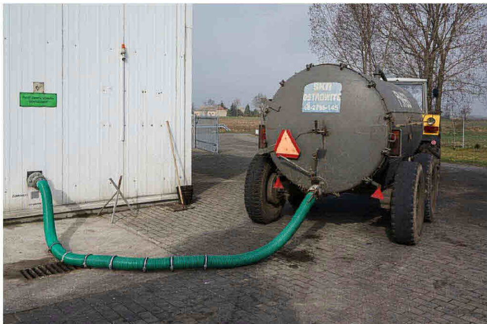
Fot 3 Punkt zlewny – zrzut ścieków
