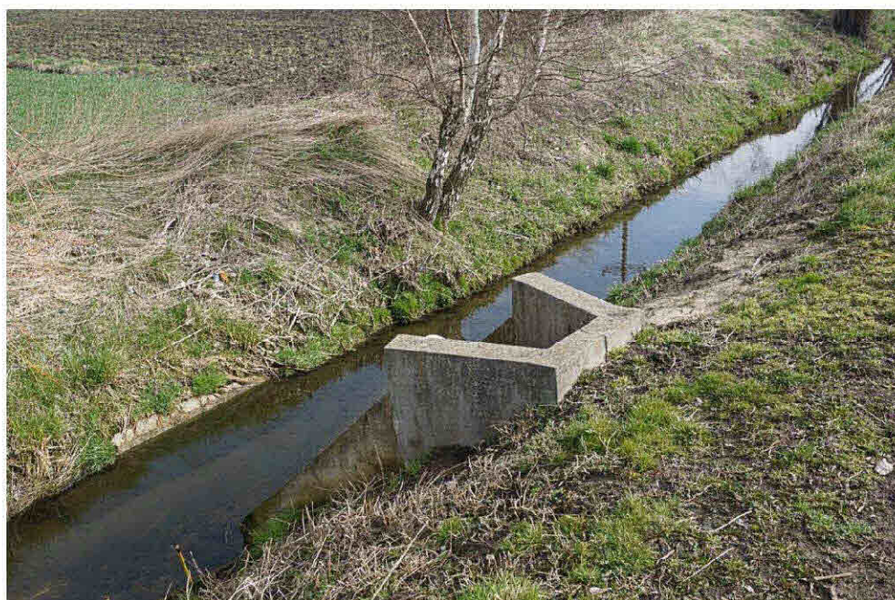
Fot 14 Wylot ścieków oczyszczonych
