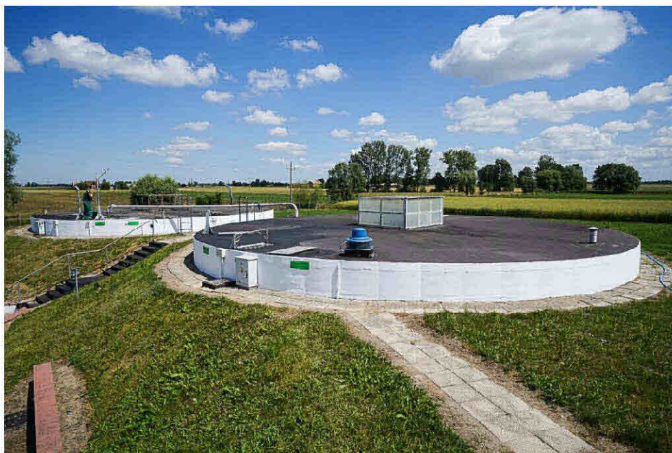
Fot 7 Reaktor sekwencyjny SBR 1
