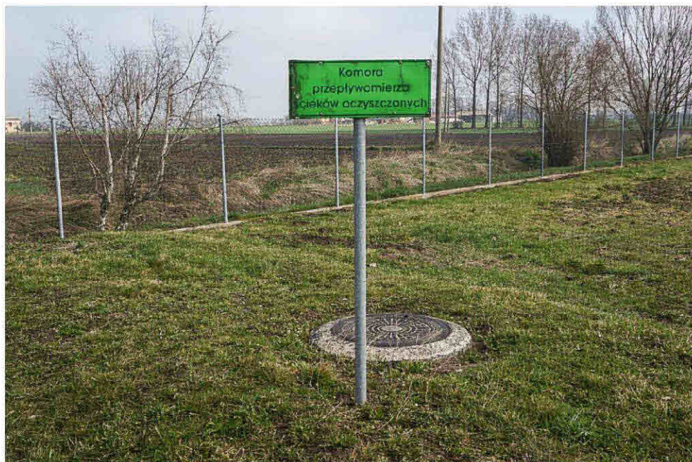
Fot 13 Komora przepływomierza ścieków oczyszczonych
