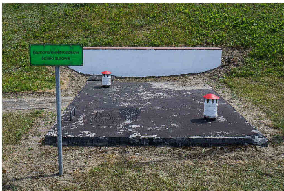
Fot 6 Komora elektroosmowa
